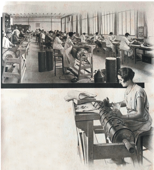
Gravat i preparació dels motlles i matrius. Fullet comercial dels anys 20 de la Fàbrica Paul Dumàs de Montreuil, Arxiu Pomar Flores.
